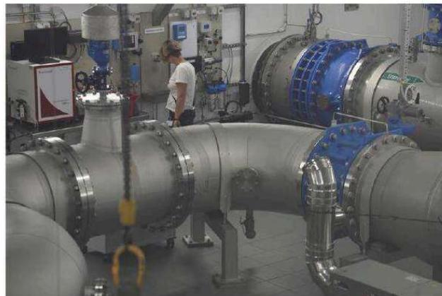
Une technicienne effectue des prélèvements pour contrôler la qualité de l'eau, dans la station de pompage des Lange Erlen à Bâle – dernière étape, avant envoi dans le réseau. L'eau est traitée aux UV pour éliminer d'éventuels agents pathogènes. Photos Vincent Voegtlin
